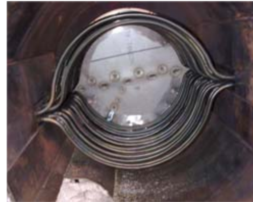
Kuva 5. Stirling- moottorin lämmönsiirtopinta ennen käyttöä.
