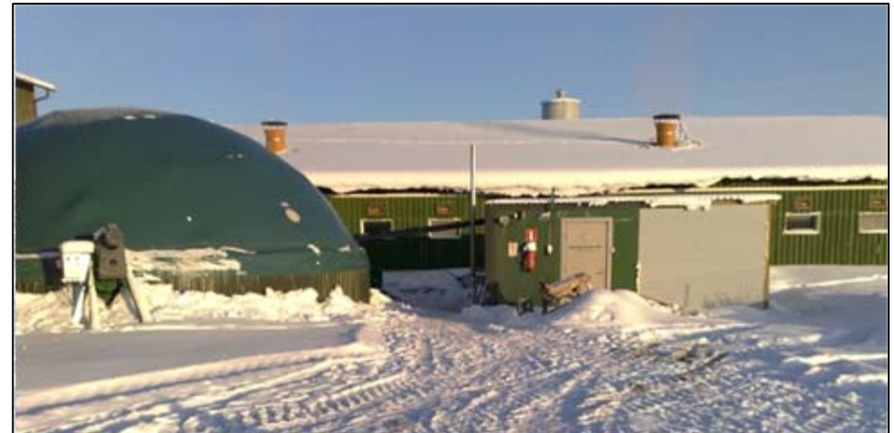
Kuva 2. MetaEnergian valmistama biokaasureaktori/yhdistetty kaasukupu vasemmalla ja tekninen tila oikealla. Virtalan tila Haapavesi. [Hannu Snellman 2010]
