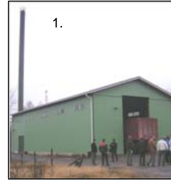
1. Hakelämmitteinen 1,6 MW th lähilämpöyksikkö, jota hoitaa energiaosuuskunta Kälvialä.
