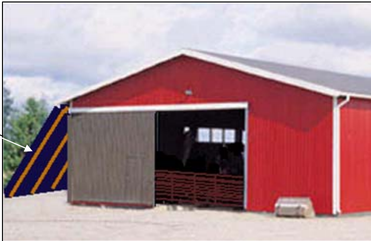
Kuivuri, jossa on yksinkertainen aurinkokerääjä ja ajonkestävä lattia
