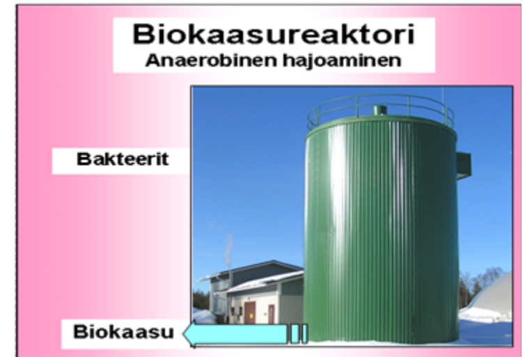
Anaerobinen mädätys (AD) biokaasureaktorissa jossa tuotetaan biokaasua (metaanikaasua), jota voidaan käyttää lämmitykseen sekä sähköntuotantoon CHP- laitoksessa.
