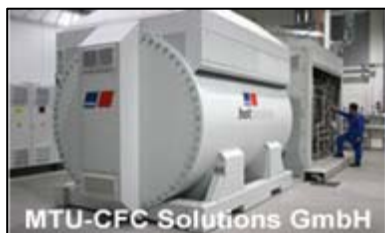
Saksalainen MTU-CFC Solutions valmistaa polttokennolla varustettuja CHP- yksiköitä. Tämän kuvan yksikön koko on 250 kWe sekä 180 kWth Kuva. MTU CFC
